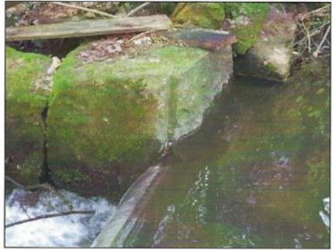
Abb. 110: Detail der Wehranlage (20.06.2019).
