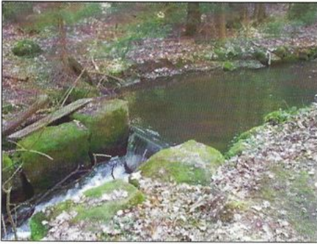
Abb. 109: Gesamtansicht der Wehranlage (20.06.2019).
