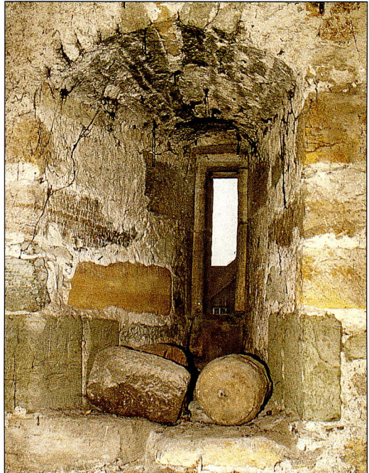
Blick in eine der insgesamt 7 Schartenkammern
