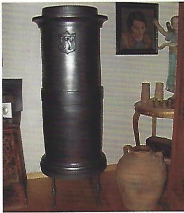
**Abb. 29:** Säulenofenhinterlader auf eisernem Fußgestell,
